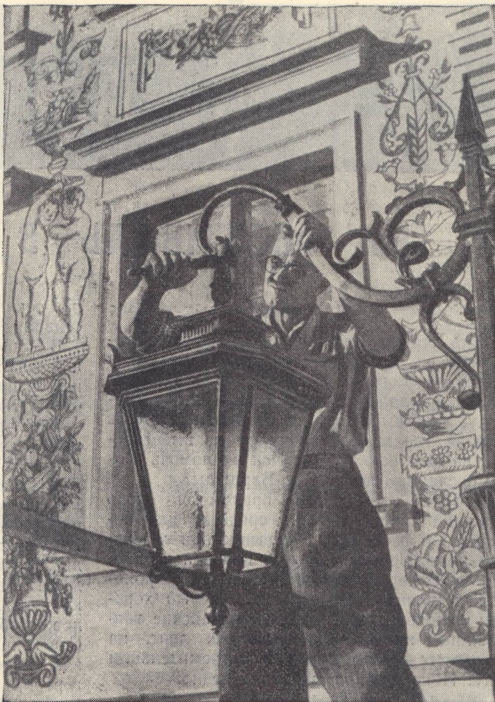
Старе Място восстанавливается во всей его древней красе. Даже фонари на улицах ставятся не литые, а кованные, как в старину.
